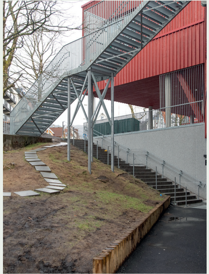
Ståltrapp ved nybygget.
